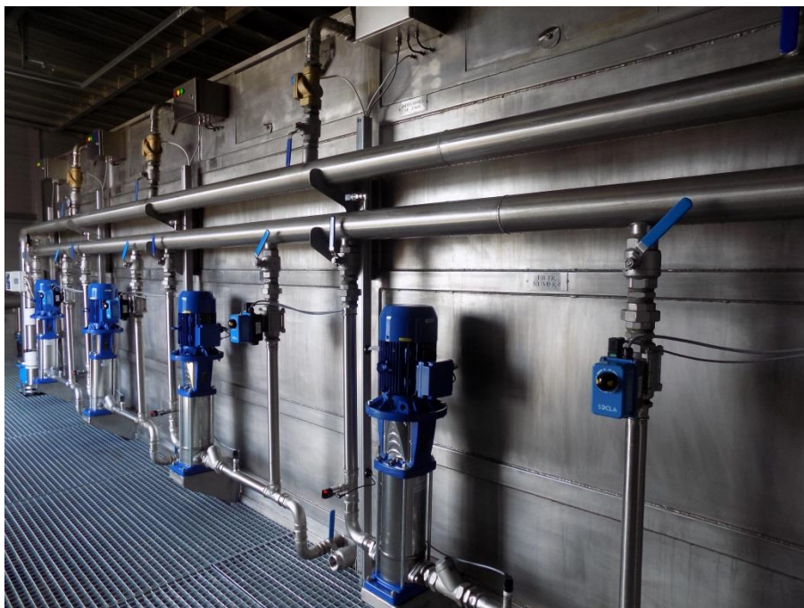
System sterownia pracą filtrów
